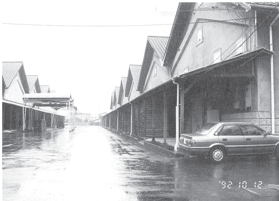
両側に12棟ある食糧倉庫
