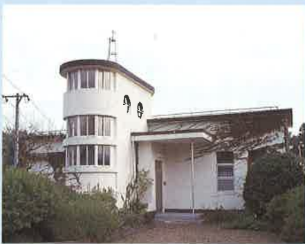
青下ダム旧管理事務所
