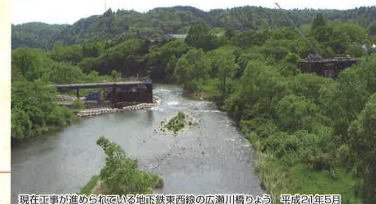
現在工事が進められている地下鉄東西線の広瀬川橋りょう 平成21年5月
