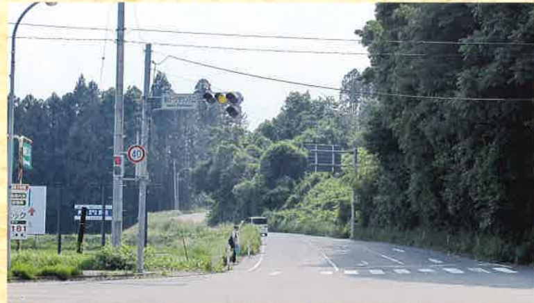
県道泉塩竈線の泉パークタウン入口交差点から西を望む 蛇行しながら丘陵を登る泉塩竈線が、古い道の面影を残している
