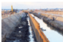
着々と復旧工事が進行
