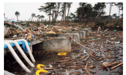
■平成23年3月21日 二郷堀排水機場
