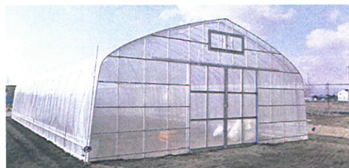
▲再建されたパイプハウス
