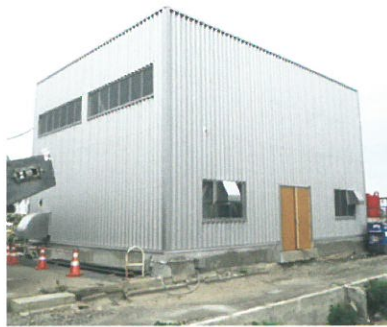
▲仮復旧後の大堀排水機場。
