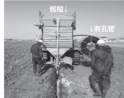
▼暗渠排水埋設状況
