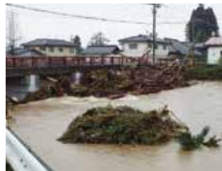
本市における洪水（河川氾濫）の被害 （平成 27 年 9 月関東・東北豪雨）
