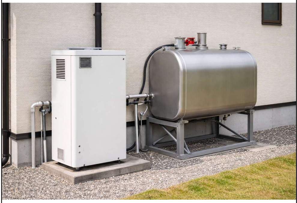
【設備使用状況写真】 ②撤去設備の使用状況写真
