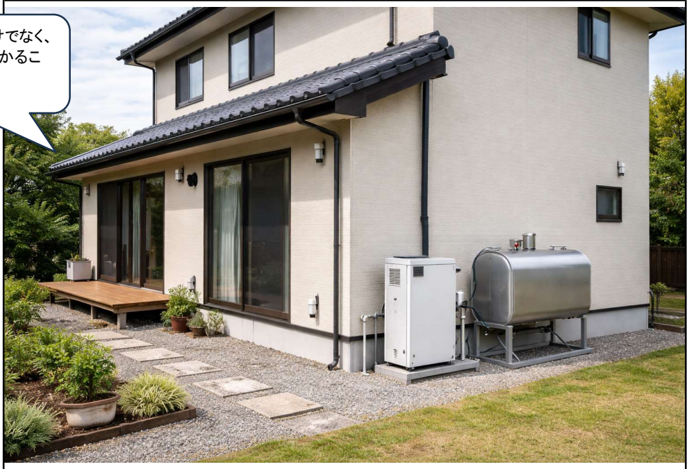
【全体写真】 ①撤去予定設備設置場所全体写真
