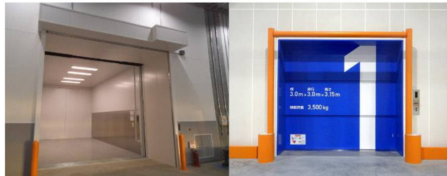
荷物運搬用エレベーター壁パネル・扉
