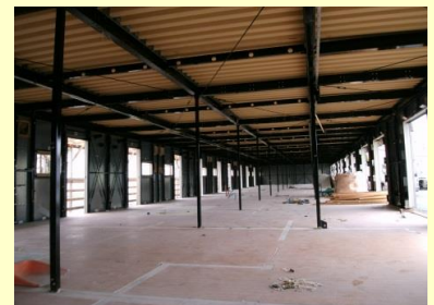
解体中の岡田西町公園プレハブ仮設住宅団地 内装と壁が取り外され、棟の奥まで見渡せる状態です。
