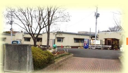
解体前の高砂一丁目公園プレハブ仮設住宅団地
