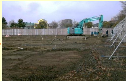
建物、舗装がなくなりました。埋設管の撤去に取りかかります。
