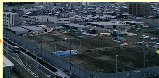
建物、舗装がなくなりました。埋設管の撤去に取りかかります。
