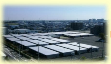
解体前の荒井土地区画整理事業小学校用地プレハブ仮設住宅団地
