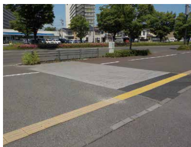
歩道舗装を利用した遺構平面表示
