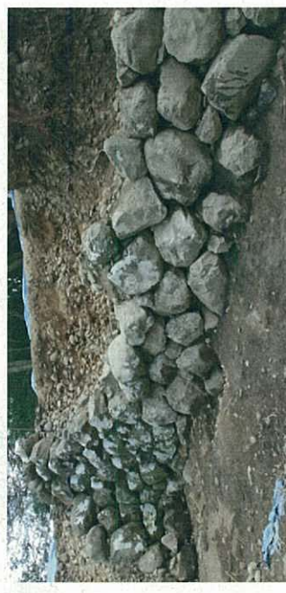
写真6 西門正面の石垣 自然石を積んだ石垣ですが、表面の一部を加工した石材が見られます。
