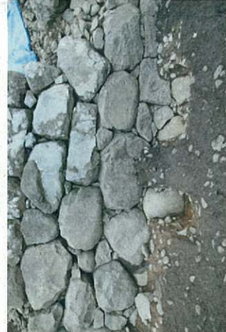
写真3 地表面下で検出した石材 地表より下で検出した石材は、盛土で覆われていました。
