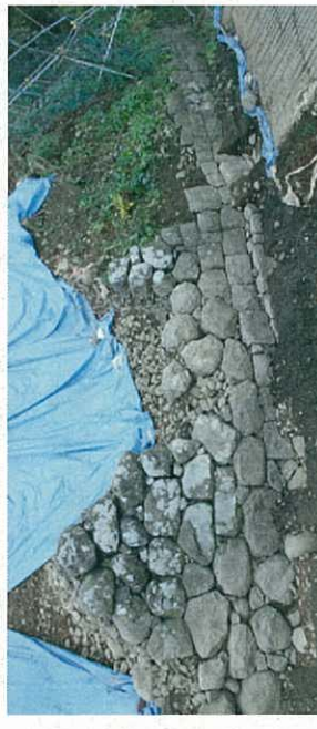
写真8 野面積みと切石積みが見られる石垣 写真中央付近で切石積みの石垣の上に野面積みの石垣のついている状況が確認できます。
