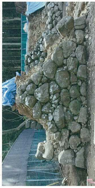
写真5 西門東脇の石垣 下の数段分は自然石をそのまま積んでおり、古い要素を残す石垣と考えられます。
