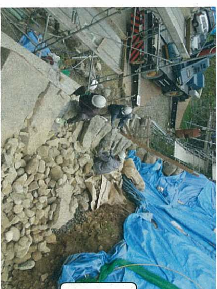
2〜3段ずつ仮積みを行い、全体的にずれが生じないかを確認しながら積み上げていきます。被災前の写真と見比べると、元の位置に戻すように慎重に作業を進めています。割れた石は、同じ形の石を作って交換しています。
