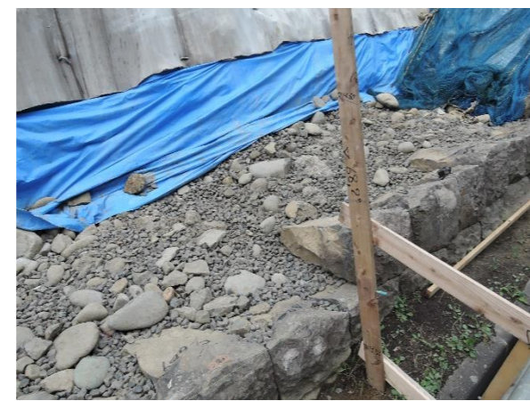
【写真4】被災前測量データを基に設置した丁張
