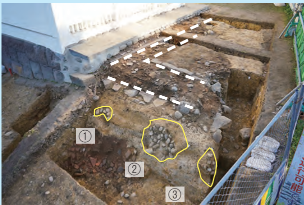
写真1: 石組側溝と礎石跡の位置関係(北西から撮影)
