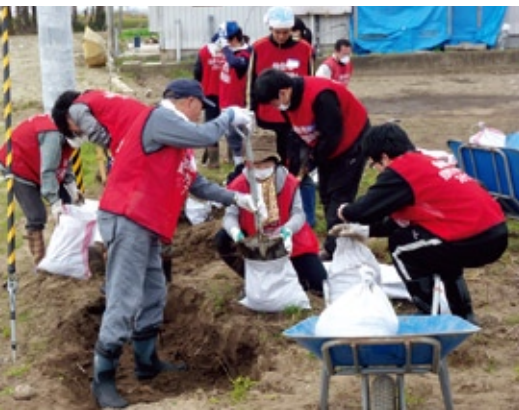
スコップでかき出した泥を土のう袋に詰め、一輪車で集積場所へ運ぶ。高圧洗浄機による壁や塀の洗浄、石灰消毒、がれきの片付けなども行った 〔仙台市社会福祉協議会提供〕
