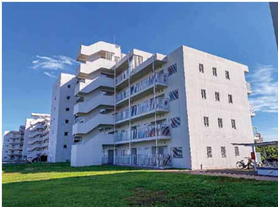
復興公営住宅
