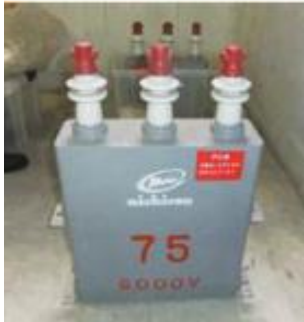
電力用コンデンサー
