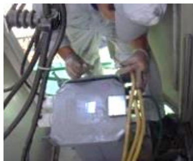
採取口がない変圧器からの絶縁油の採取
