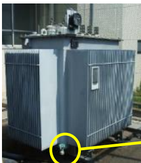
採取口付きの変圧器からの絶縁油の採取
