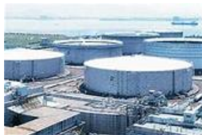
石油貯蔵タンク
