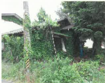
《管理不全な空家等の例》
