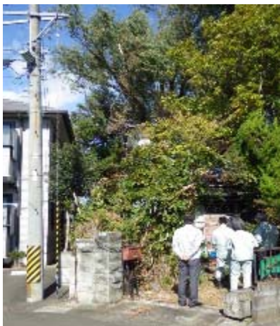
区役所職員による調査
