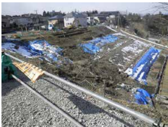
写真 南光台六丁目地区（復旧前）
