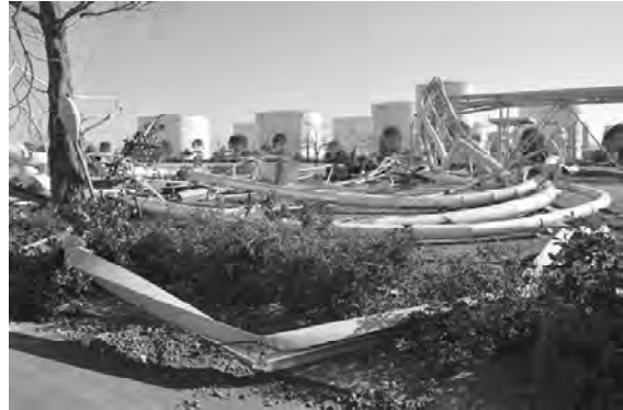
写真 ガス局港工場の津波被害
