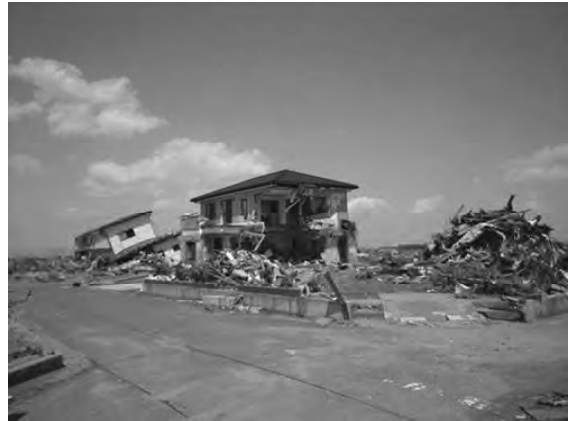
写真 若林区深沼の津波被害
