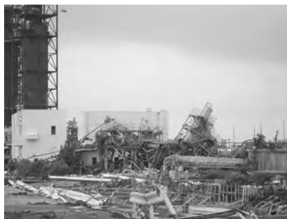
(電気・機械設備等が破壊され津波によるがれきが散乱)
