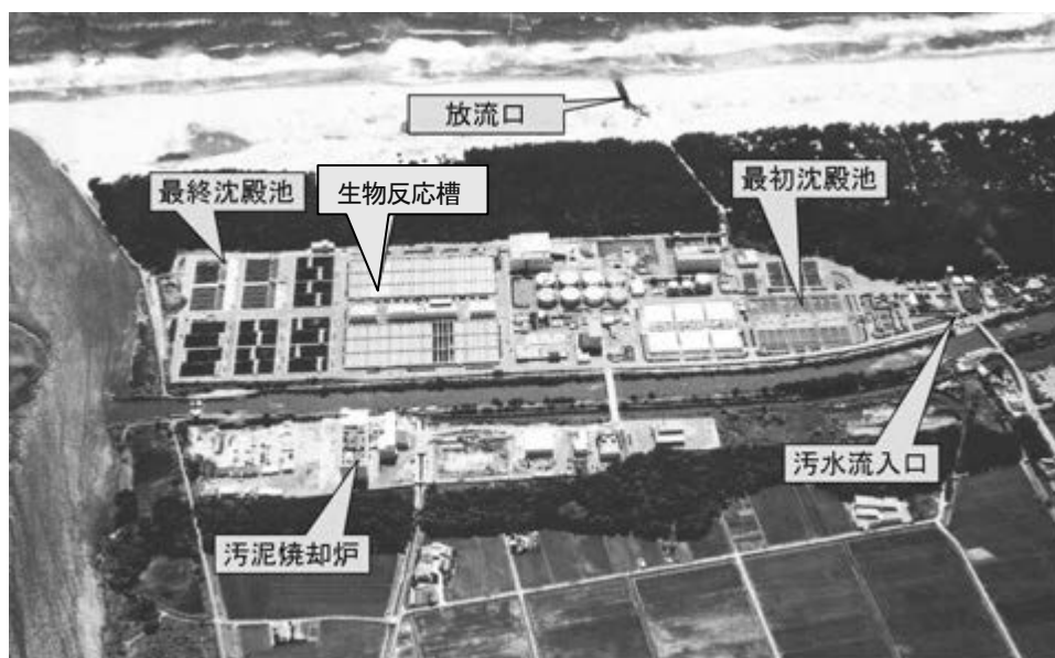
写真 南蒲生浄化センター全景
