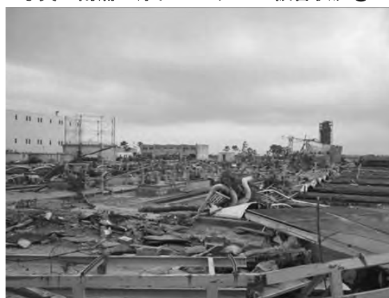
写真 南蒲生浄化センターの被害状況①
