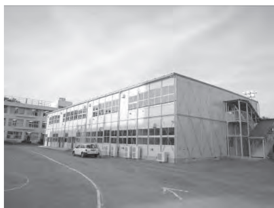
写真 完成した仮設校舎（西多賀小学校）
