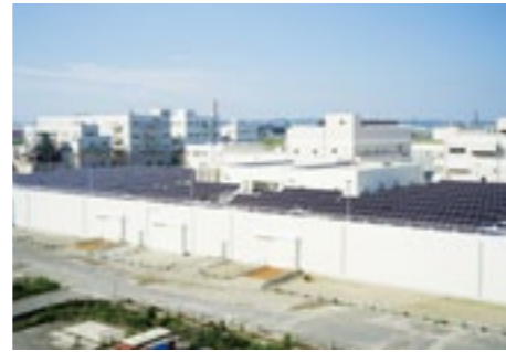
南蒲生浄化センターの新水処理施設が完成(4月)
