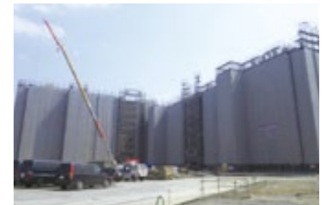
建設が進む荒井東復興公営住宅
