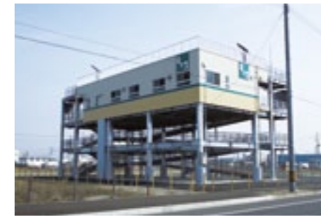
中野5丁目津波避難タワーが完成(2月)
