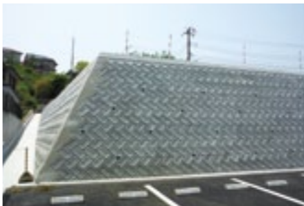
松森字明神地区の宅地復旧工事が完了
