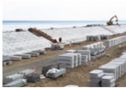
海岸堤防のかさ上げ工事
