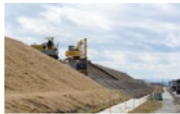
かさ上げ道路の整備が進む
