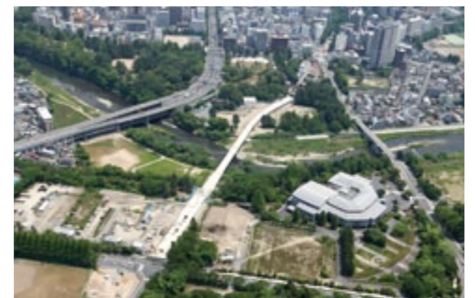
建設中の地下鉄東西線国際センター駅と広瀬川橋りょう
