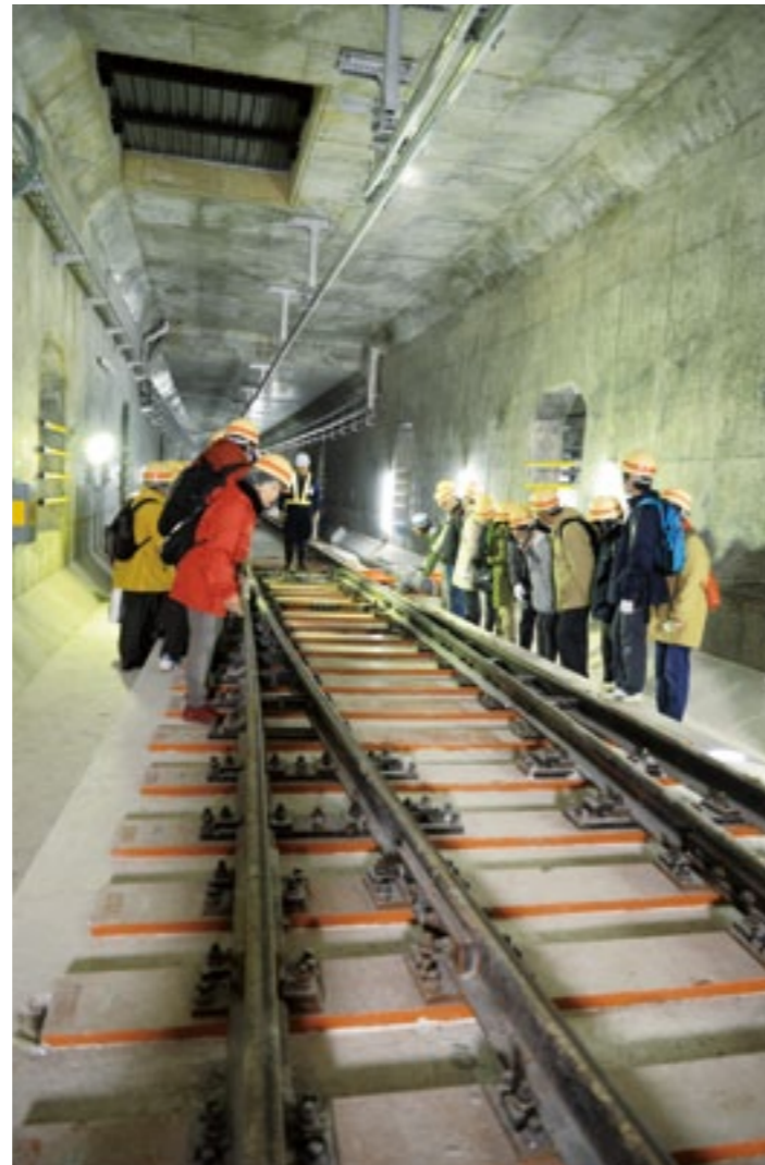
建設中の地下鉄東西線線路でトンネルウォーク(11月)
