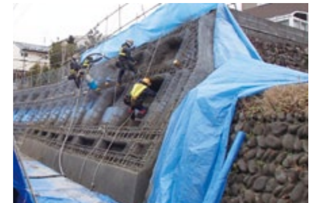
被災宅地の復旧工事(太白区青山2丁目)
