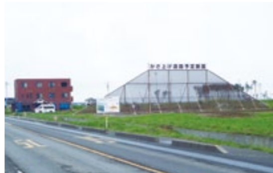
かさ上げ道路の実物大モデルを設置
