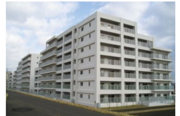
若林西復興公営住宅に入居が始まる(4月)
