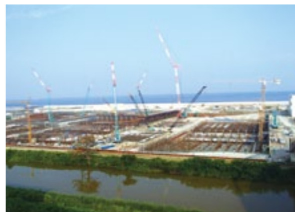
復旧工事が進む南蒲生浄化センター
