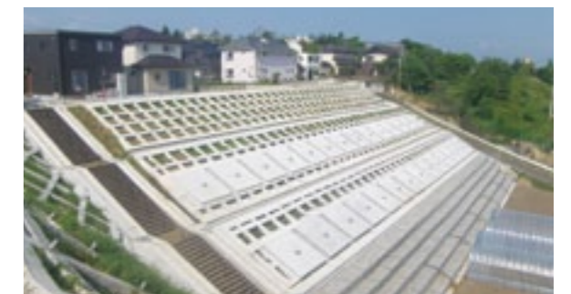
宅地復旧工事が完了した南光台6丁目地区(8月)
