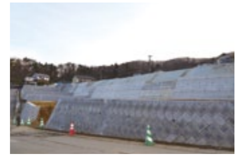
宅地復旧工事が完了した折立5丁目地区(1月)
