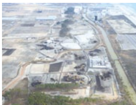
12月にがれきの処理が完了。原状復旧が進む海岸公園
