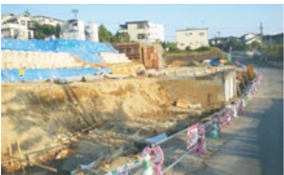
復旧中の折立5丁目（平成26年ごろ）。地すべりを防止するための地盤改良工事などが行われている。
