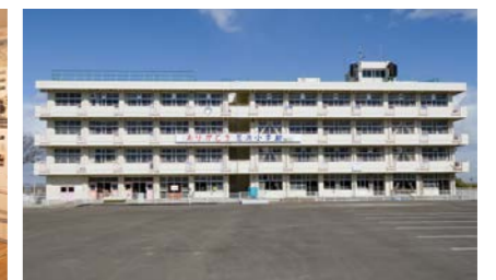
震災遺構 仙台市立荒浜小学校
