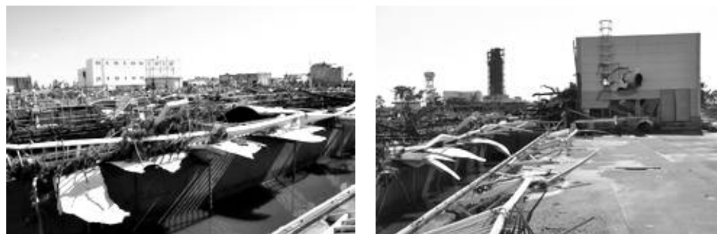
南蒲生浄化センター(下水処理施設)
