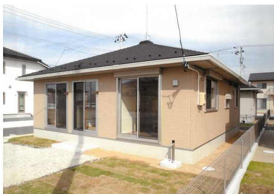
建物全景（田子西第四地区）
