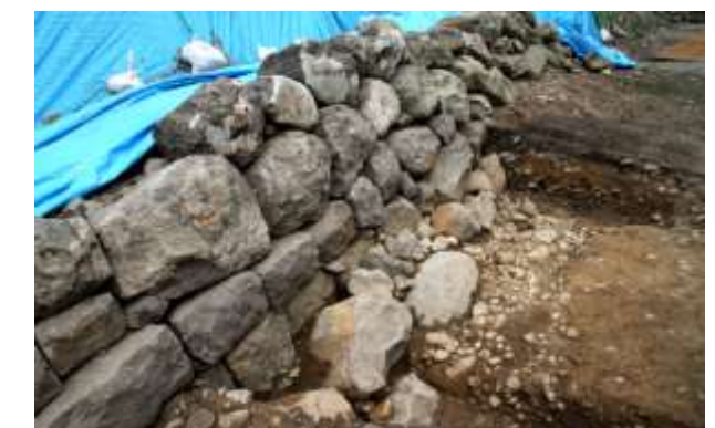
図5 本丸北西石垣修復工事に伴う調査
