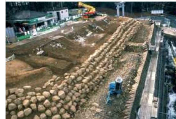
図4 本丸北壁石垣修復工事に伴う調査
