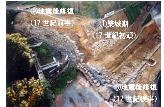
図3 本丸北壁石垣修復工事に伴う調査
