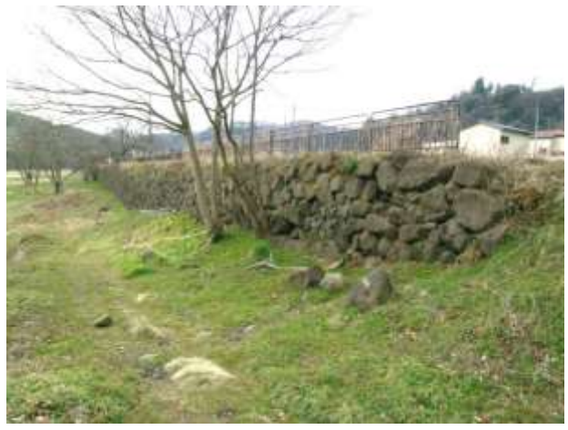
図7 広瀬川護岸石垣測量調査 平成15~17・21年度に石垣の測量調査を行った。
