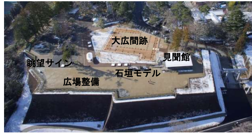
図2 本丸広場整備・大広間跡遺構表示整備 広場の舗装・仙台城見聞館建設・石垣モデル設置・眺望サイン設置等
