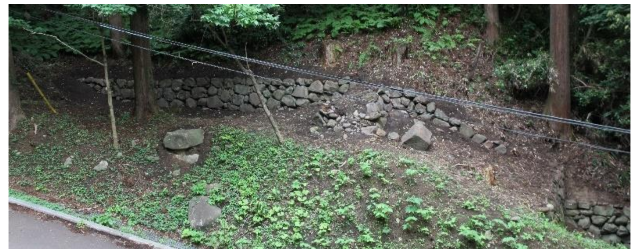
図 17 清水門北側石垣全景（南東から、20190708 撮影）
