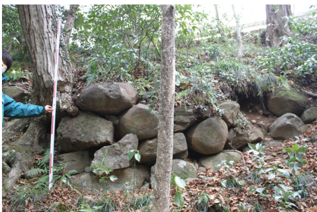
②本丸北西壁下石垣(北西から)
