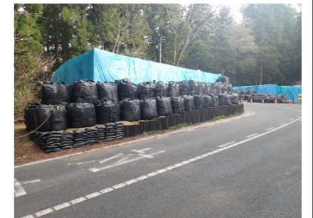
応急措置完了後
