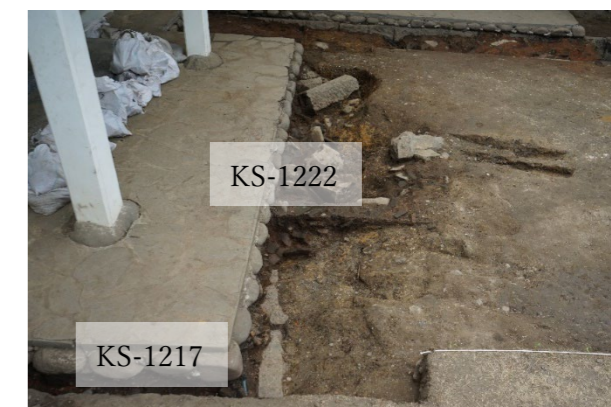
写真12 KS-1222 検出状況 (西から)
