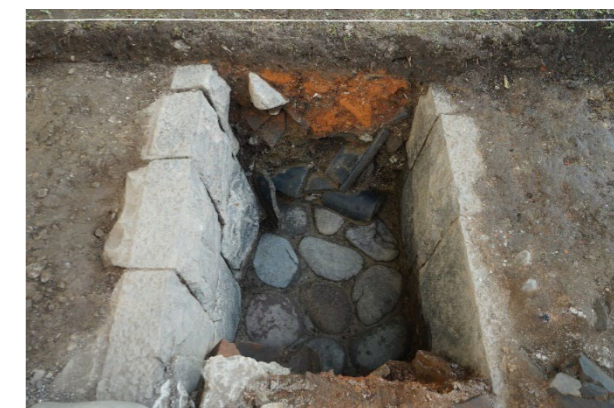
写真20 南東サブトレ：石組側溝断面(北から)
