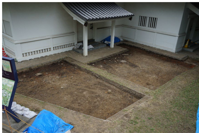
写真4 II層上面遺構検出状況(南西から)
