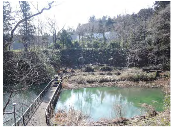
写真② 伐採後：北から撮影（令和6年冬）
