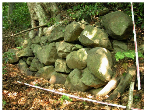
写真④ 石垣近景 (北から撮影：2003年頃)
