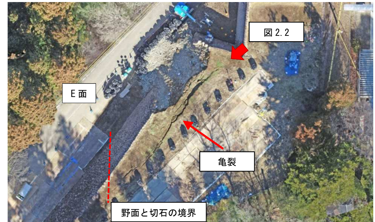
図 2.1 E面解体前上空写真
