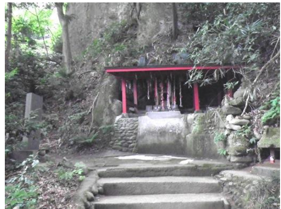
崖面崩落前の蛸崎神社【2018 撮影】(東から)
