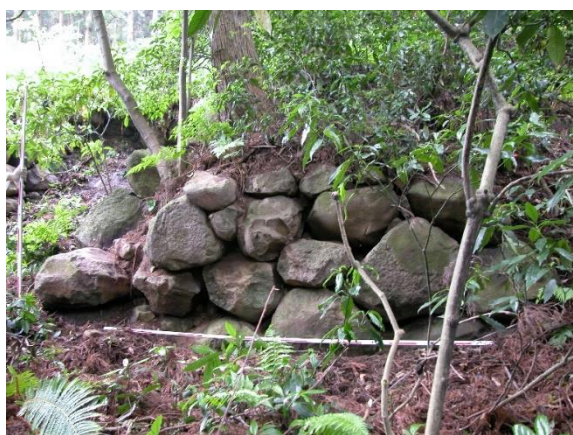
E面崩落前【2003年撮影】(北から)
