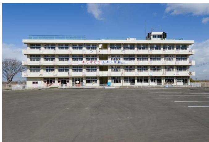
震災遺構 仙台市立荒浜小学校
