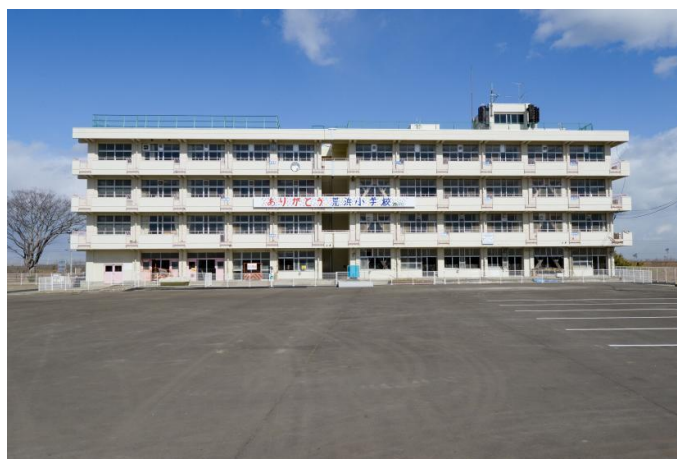
震災遺構 仙台市立荒浜小学校
