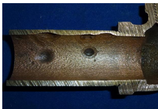
空調設備配管内部の状況
