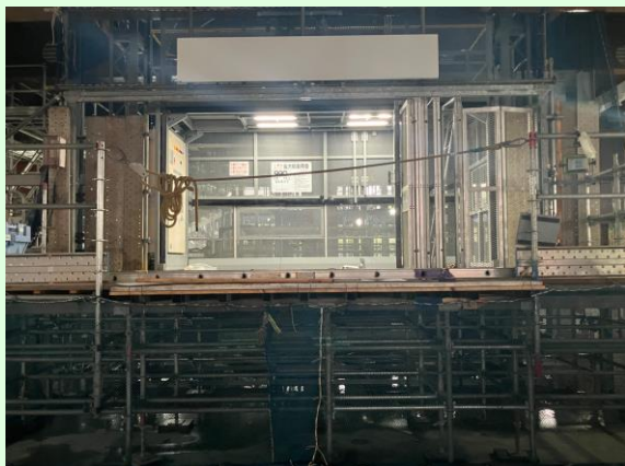
仮設エレベーター組立完了の様子
