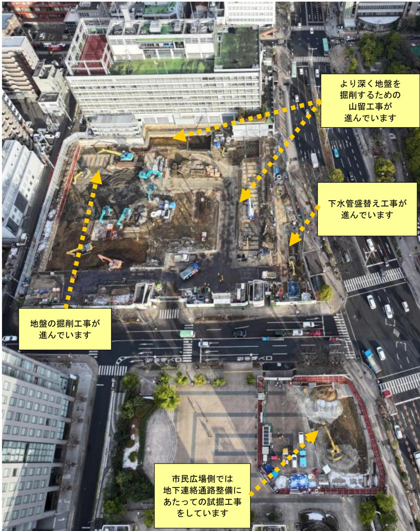
より深く地盤を掘削するための山留工事が進んでいます
