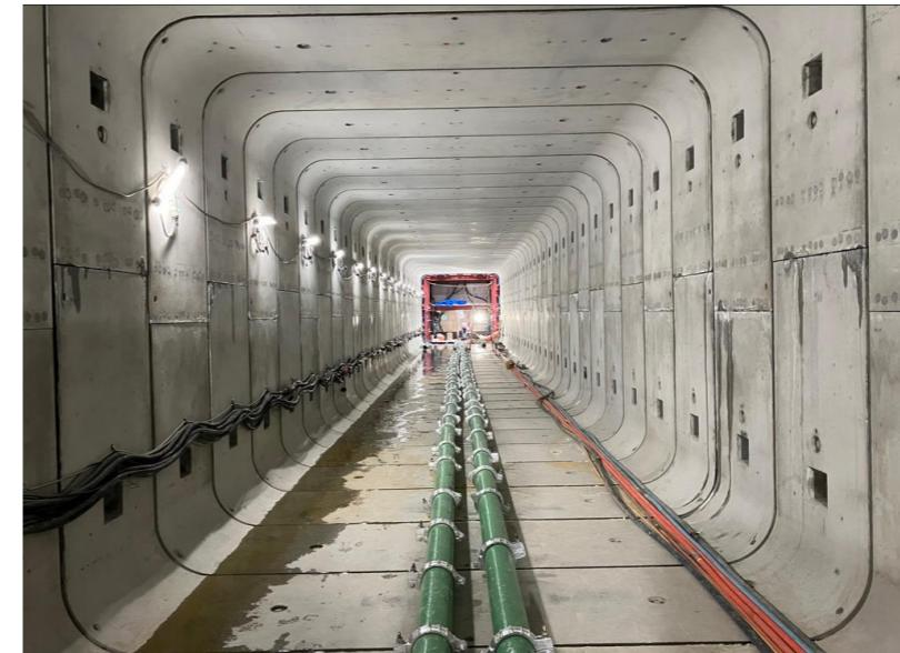
市民広場側から新本庁舎側へ向けて地中では推進機による掘進とボックスカルバートの設置工事が進んでいます。全長約57mの地下鉄連絡通路も残すところ残り数mです。
