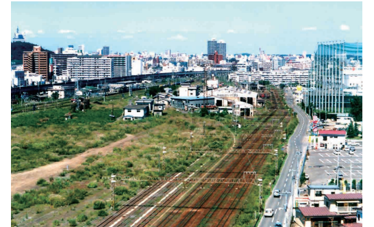
貨物ヤード跡地
