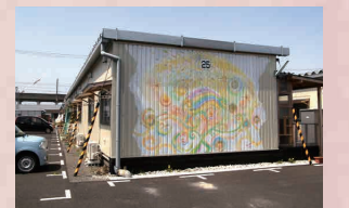
応急仮設住宅
