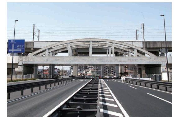
郡山折立線交差部
