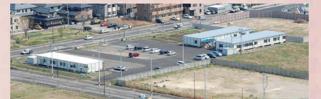
グループホーム型の福祉仮設住宅
