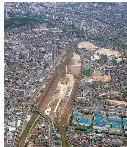
工事着手時の状況
