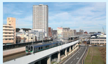
高架化工事が完了したJR東北本線
