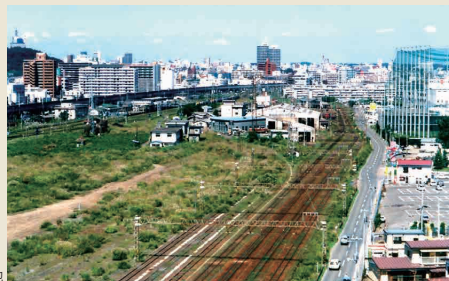
貨物ヤード跡地
