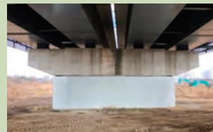
▲橋りょうの耐震補強工事
